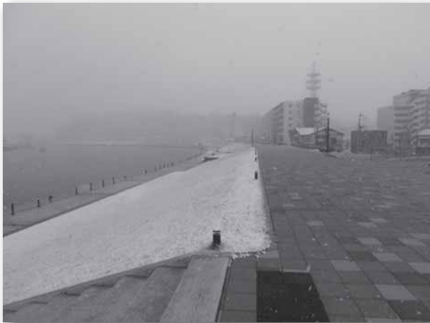
△作業区域内の完成後の堤防。 左側は旧北上川。(中央2丁目付近)
