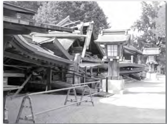
※写真「全壊した重要文化財阿蘇神社楼門」
