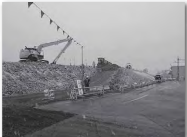
△作業区域内の堤防工事 (住吉町一丁目付近)
